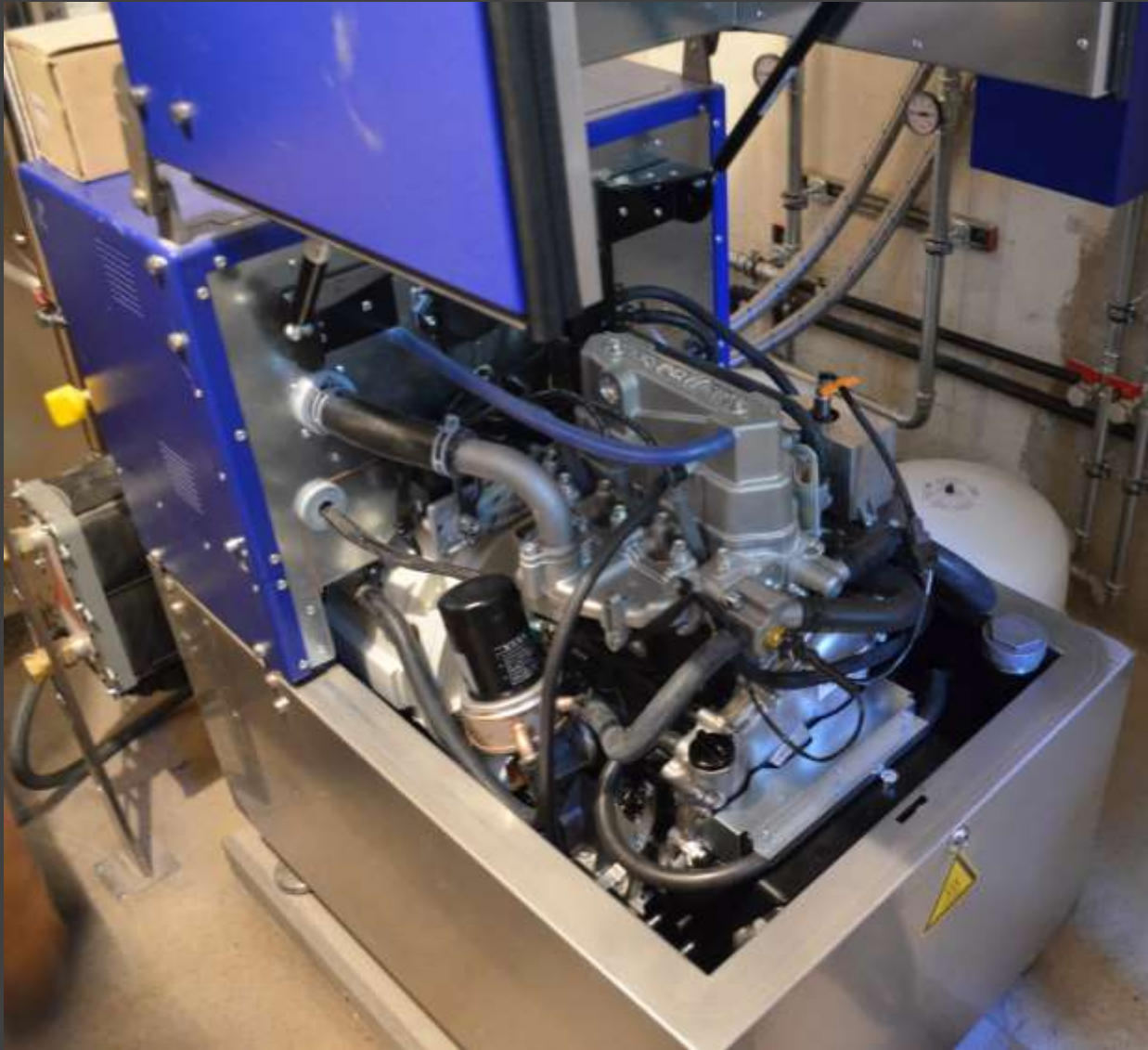
Blockheizkraftwerk (BHKW)
